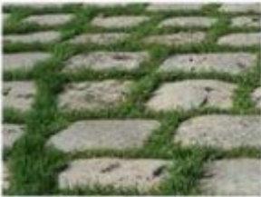
Pavés à joints engazonnés
