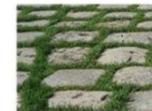
Pavés à joints engazonnés
